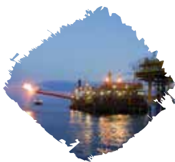
FPSO Balikpapan Kalimantan Timur East Kalimantan
