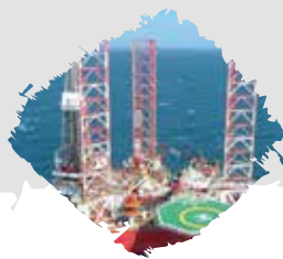
Raniworo Balikpapan Kalimantan Timur East Kalimantan
