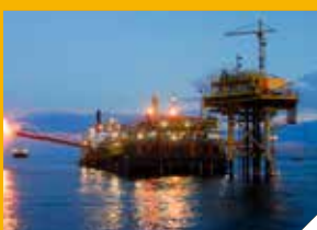
FPSO Selat Madura, Jawa Timur Madura Strait, East Java
