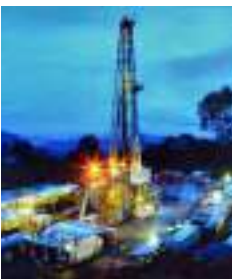
Rig 10 Suban Sumatera Selatan South Sumatera
