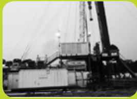
Rig 15 Suban, Sumatera Selatan
