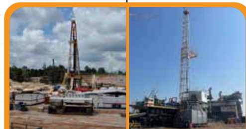
Rig 9 & Rig 14 Bojonegara Yard, Cilegon - Banten
